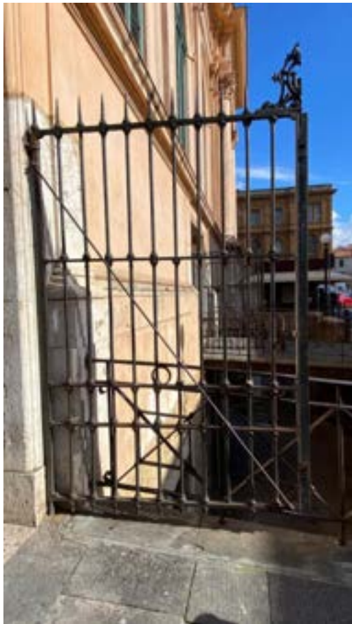
Particolare cancello laterale
