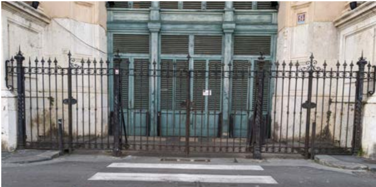
Cancello installato su ingresso principale del Mercato Centrale da inserire sul Fosso Reale
