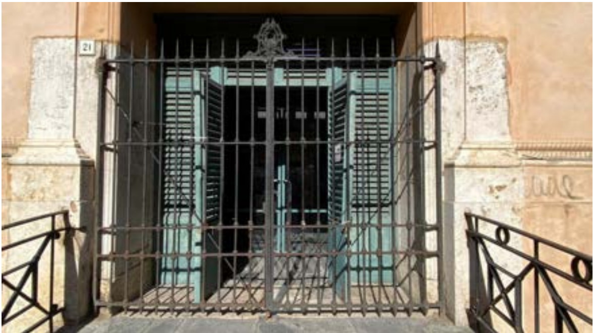
Cancello installato su ingresso laterale del Mercato Centrale da inserire sui fossi della Venezia
