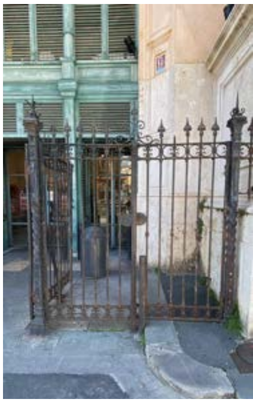
Particolare cancello ingresso principale
