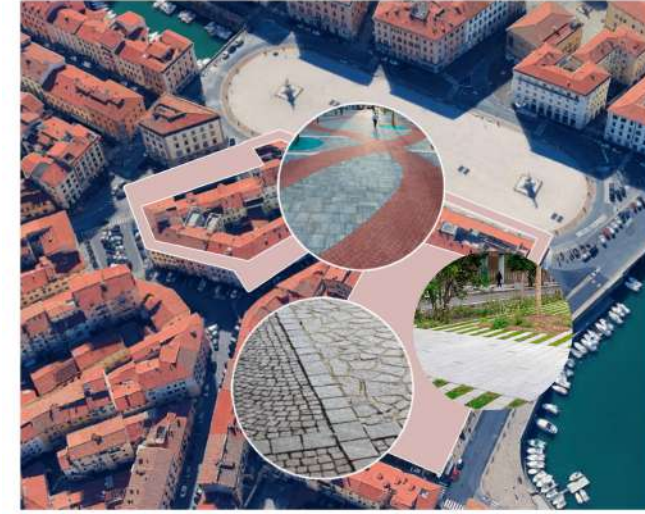
PIAZZA GARIBALDI FASE 3-NUOVA PAVIMENTAZIONE PEDONALE
