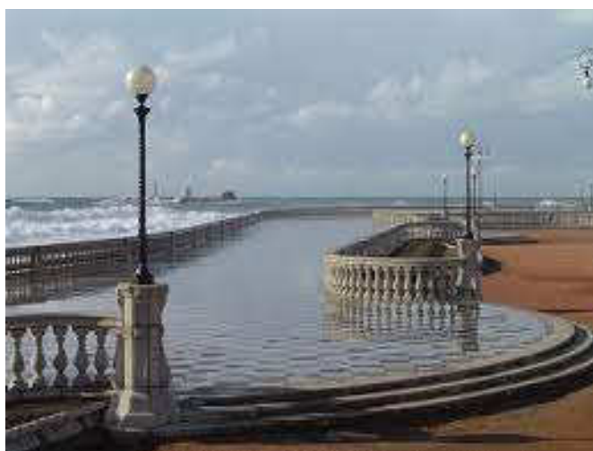
Marzo 2007, contaminazione del mattonellato della Terrazza con 15 cm. di idrocarburo pesante
