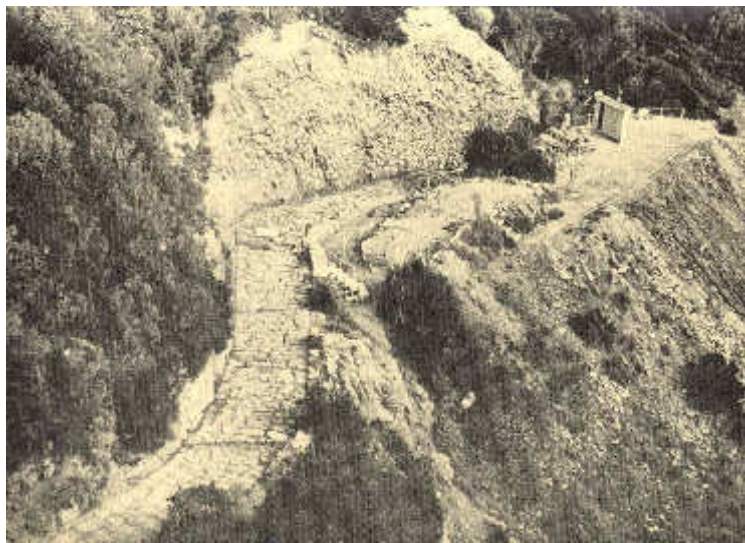
Scavi eseguiti intorno al 1978 dal Sig. Aliboni che portarono alla luce il tracciato dei Cavalleggeri in prossimità di Calignaia (ora nuovamente scomparso)
