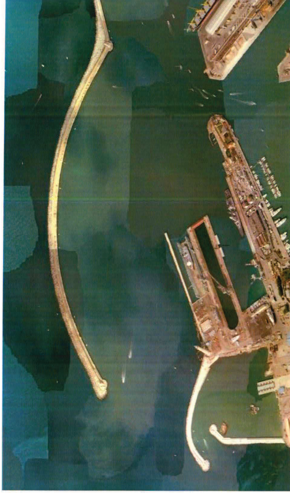
Avamposto e diga curvilinea
