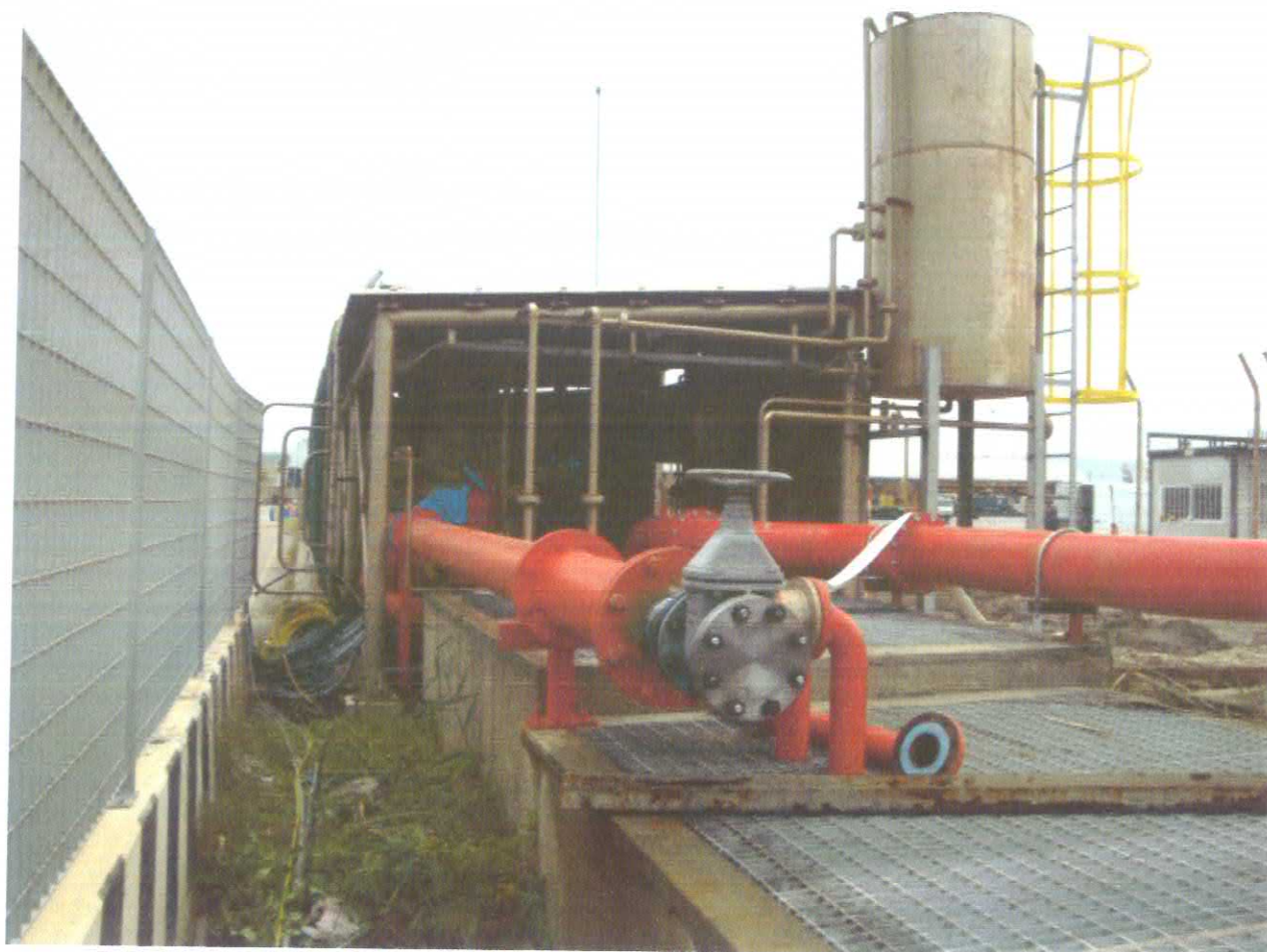
Foto 2 Particolari della stazione antincendio emergenza con motopompa diesel e pozzetti aspirazione dell'acqua di mare (in primo piano ) e serbatoio di innesco
