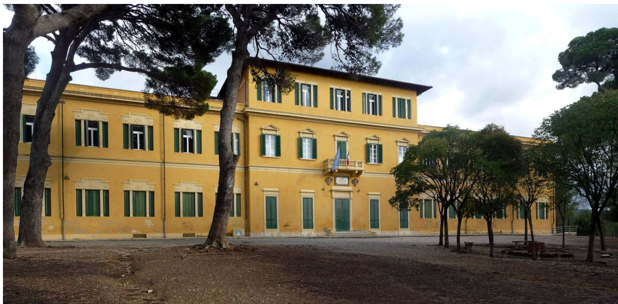
Veduta edificio principale del complesso oggi adibito a struttura scolastica - Di Lucarelli - Opera propria, CC BY-SA 3.0, https://commons.wikimedia.org/w/index.php?curid=5526994
