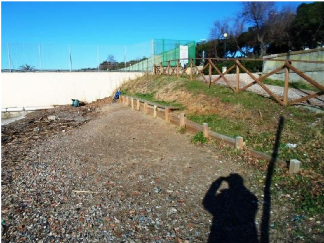
Sopra: primo piano angolo nord della spiaggia, con modesta opera di contenimento in legno alla base della scarpata. Accumulo preferenziale di materiali grossolani in questa zona.
