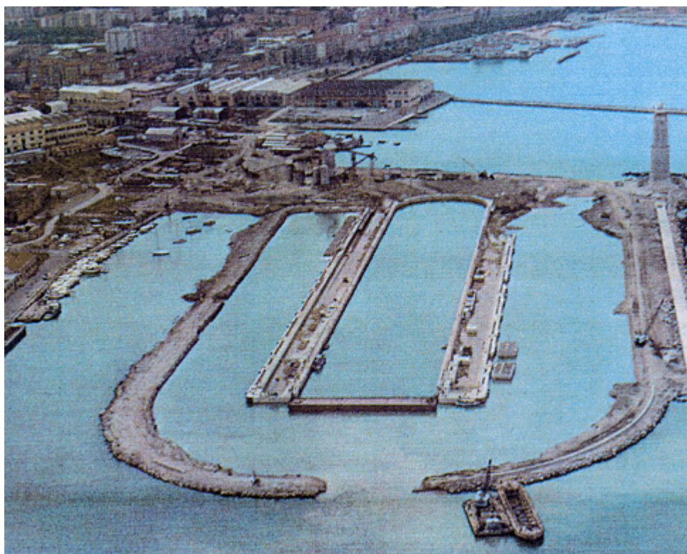
Figura 19-Il Grande Bacino in costruzione - 1974
