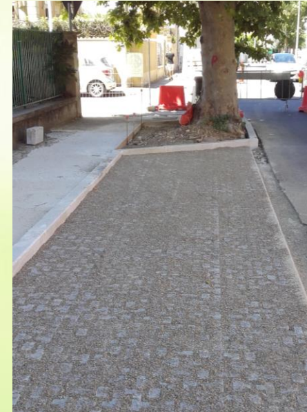
4- Stesa di pavimentazione in massello inerbante
