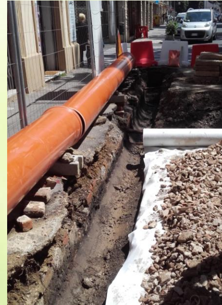
3- Massicciata in pietrisco stabilizzato e posa in opera di geotessuto
