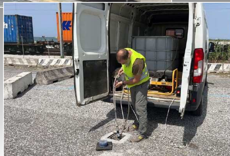
4. Realizzazione e spurgo piezometro
