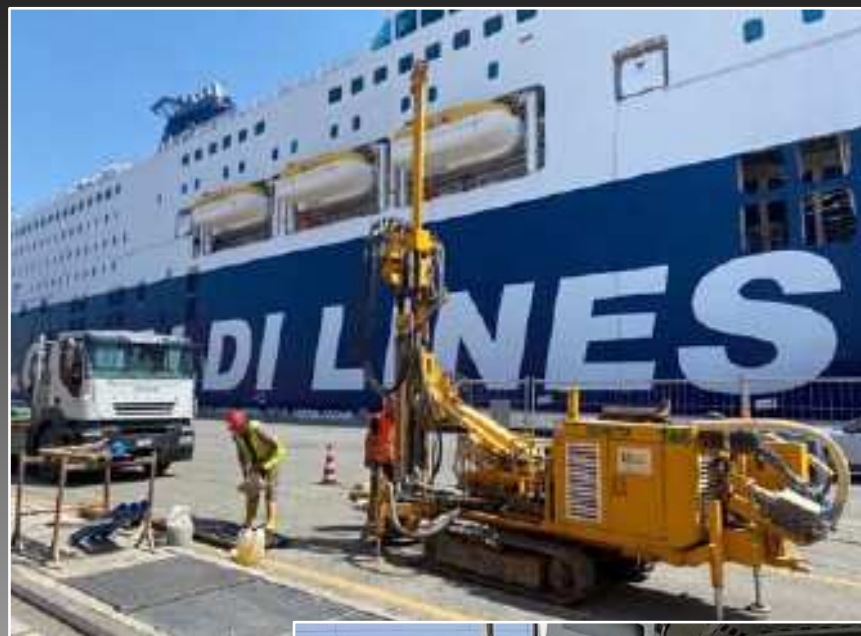
2. Sonda perforatrice per esecuzione sondaggio.
